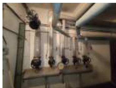
Rozvádzač Sobášna s.
